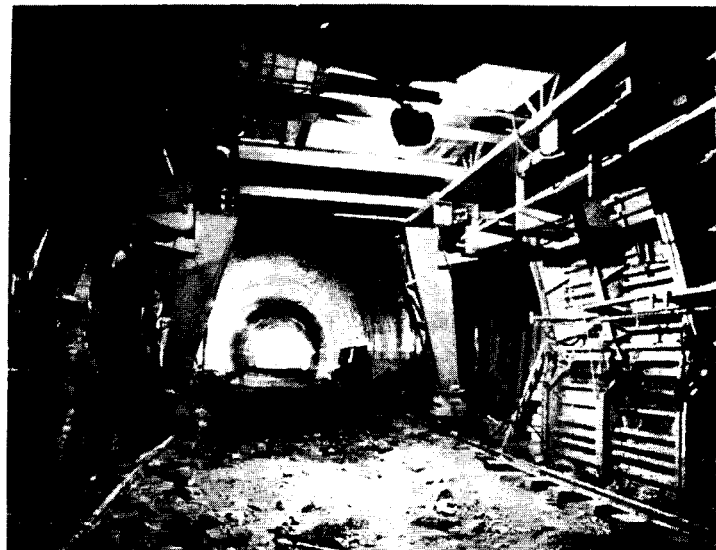
El molde deslizable "Sacma" y el túnel propiamente dicho. Vista hacia el falso túnel y la entrada.
