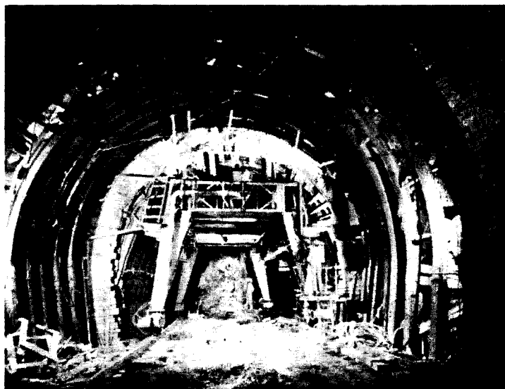
El molde deslizable "Sacma" y el túnel propiamente dicho. Vista hacia el falso túnel y la entrada.
