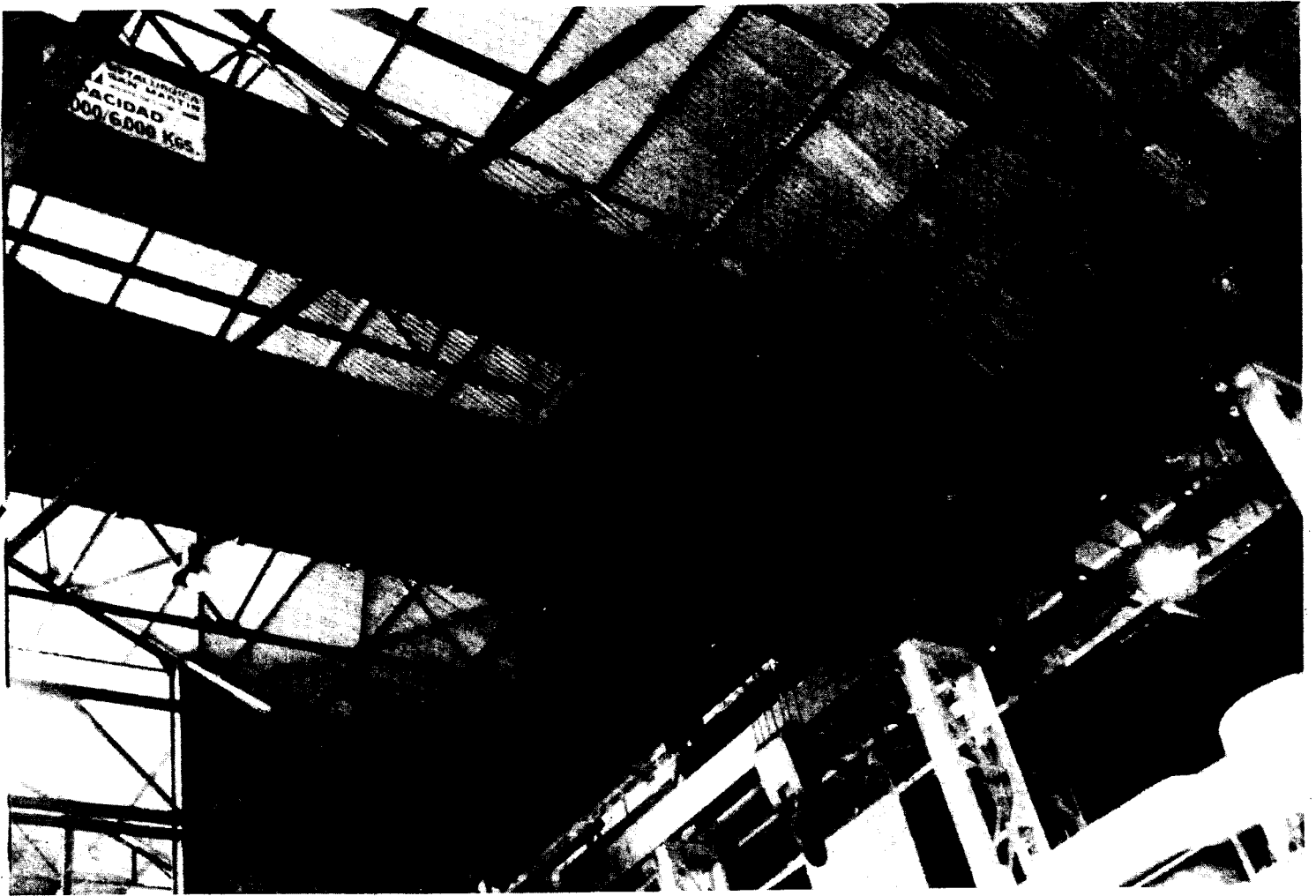
Vista parcial de un puente grúa de 18/6 Tn.
