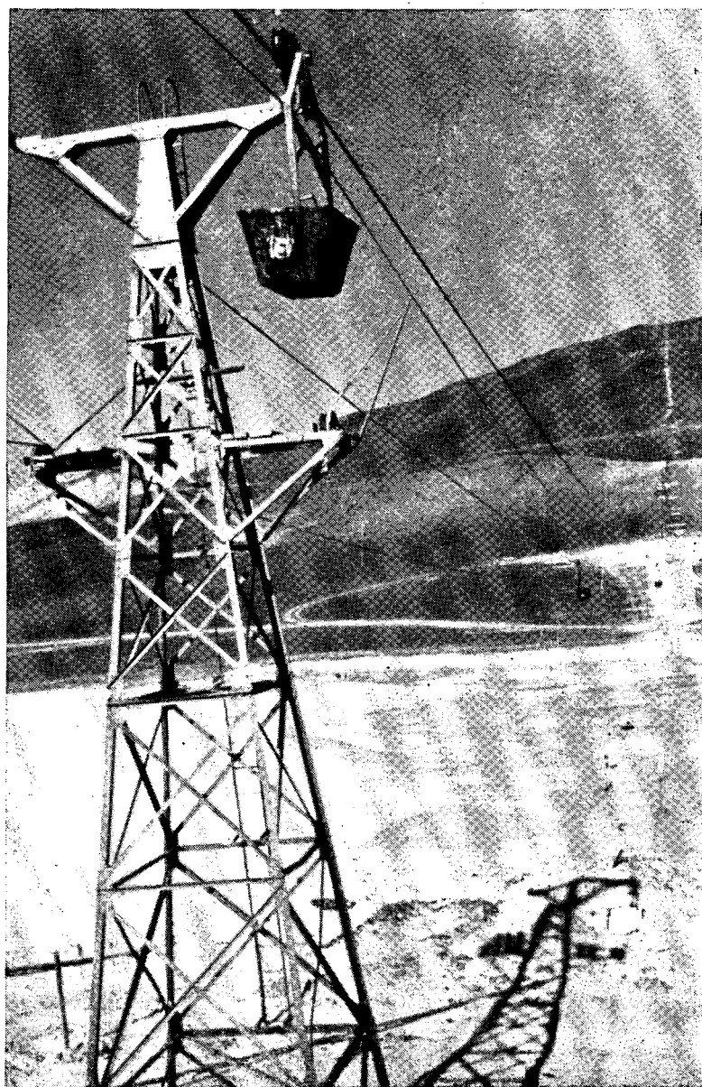
Sistema de cable carril en el Establecimiento Azufrero Salta. Tiene 27 kms. de extensión y es utilizado para el trasporte del material.
