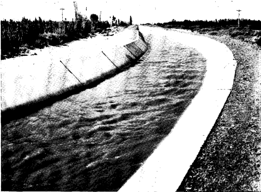
Impermeabilización de canales de la red general, actualmente en funcionamiento
