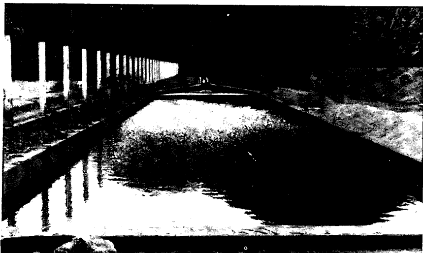
Filtro dinámico utilizado para el envío de agua filtrada a la cisterna.
