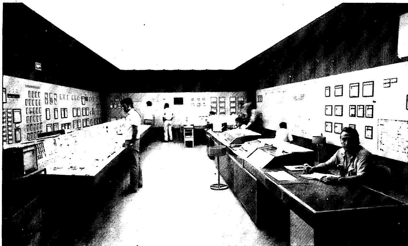
Sala de comando de la Central Nuclear Atucha I.
