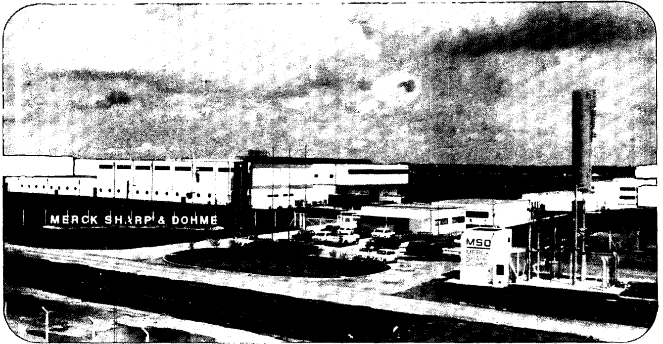
Una vista externa de la moderna planta que recientemente inauguró la empresa Merck, Sharp & Dohme, en la localidad de Pilar, provincia de Buenos Aires.
