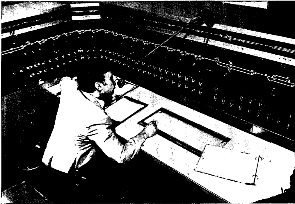
Sistema de comando de maniobras ferroviarias.
