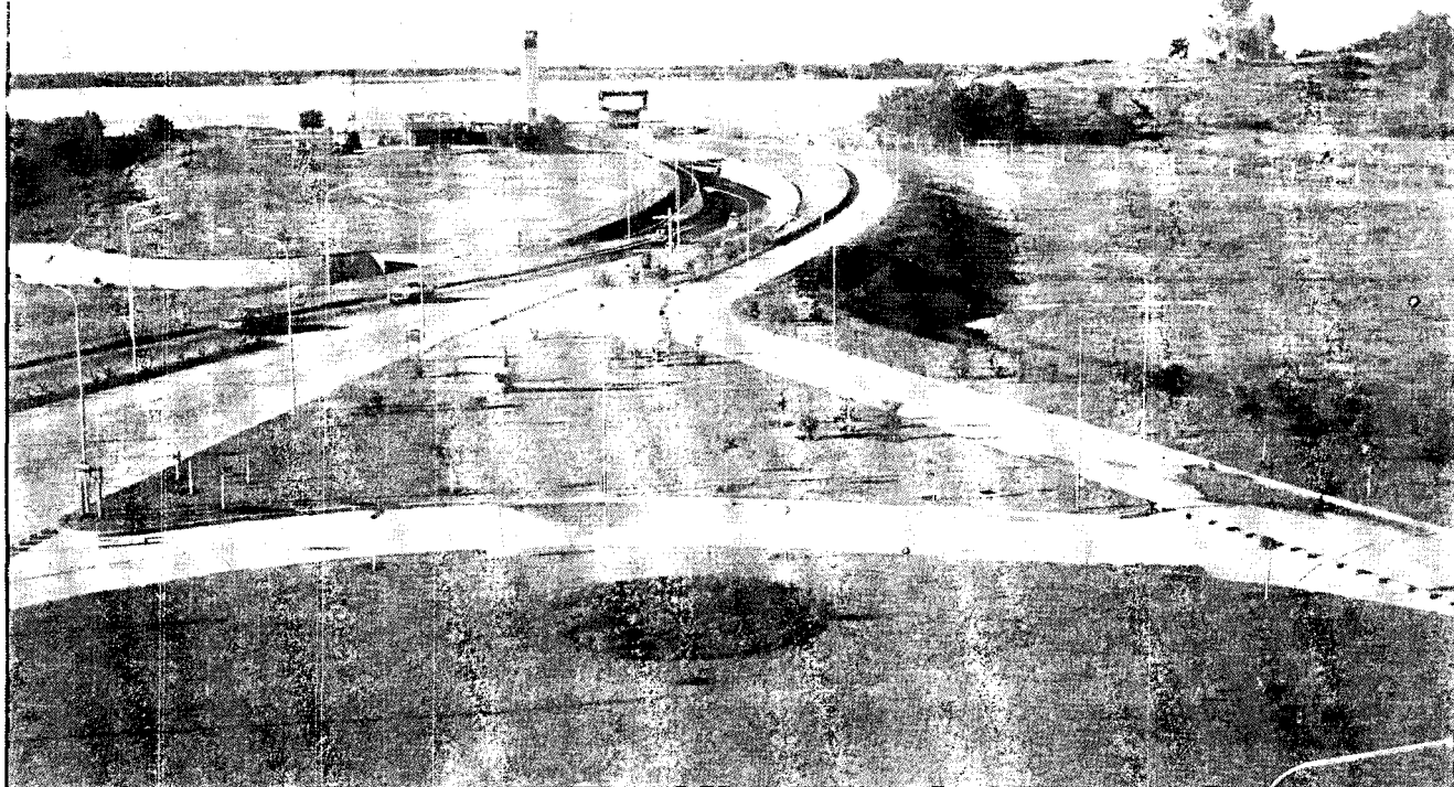
Acceso al túnel subfluvial "Hernandarias" que vincula a la capital de Santa Fe con Paraná, capital de la provincia de Entre Ríos.
