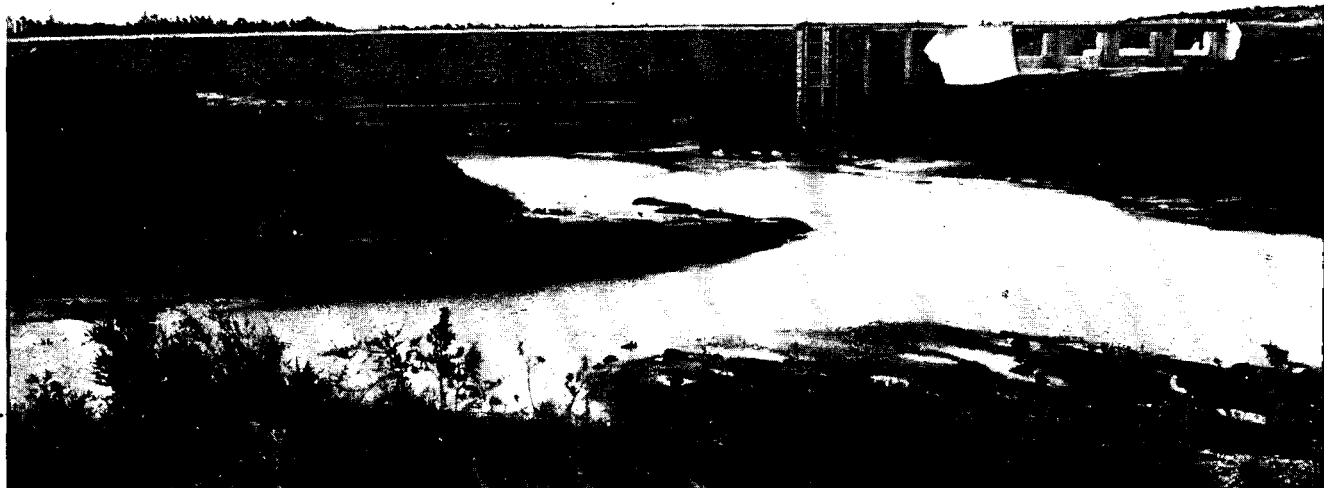
El dique compensador visto desde aguas arriba.
