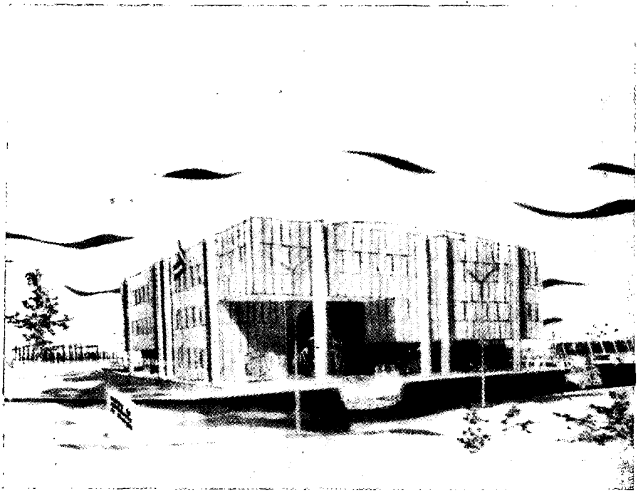
Proyecto del edificio para el Centro de Movimiento de Energía, que está construyendo SEGBA en terrenos de la Central Costanera
