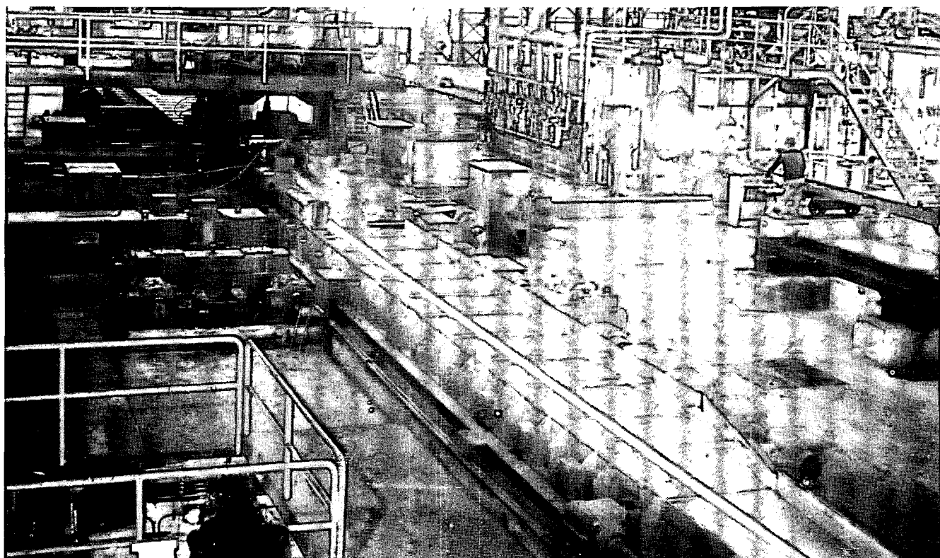
Tren de Barras: Horno de empuje y Duo reversible.
