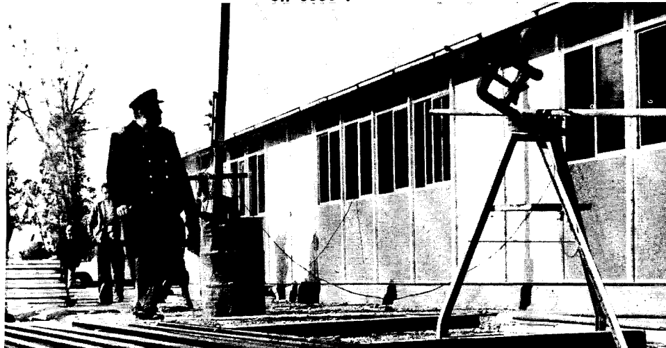
La nueva escuela se está construyendo por el sistema denominado "en seco".
