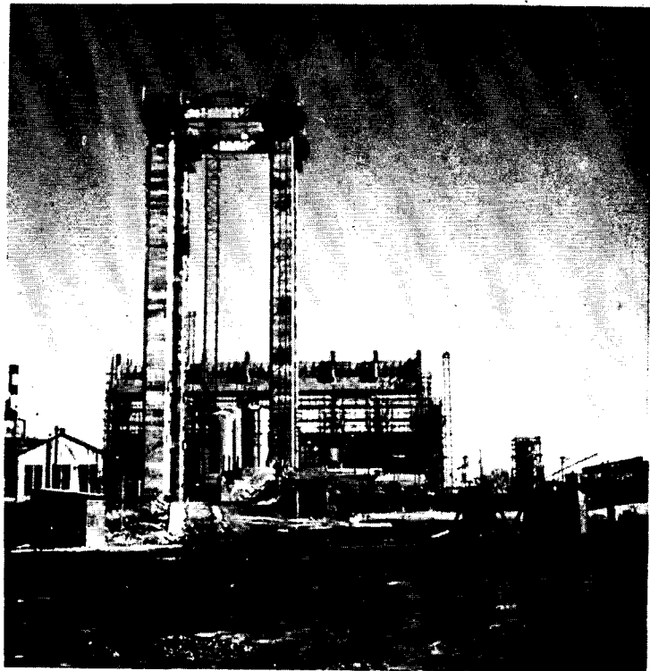
Sobre la margen izquierda del río Paraná se está construyendo la central termoeléctrica Sorrento "B", en la ciudad de Rosario.
