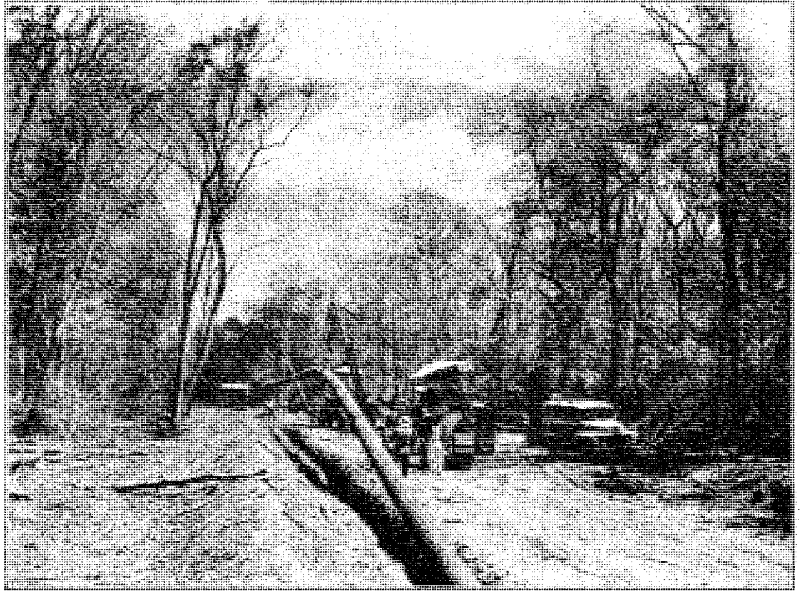
Tendido del Gasoducto del Norte
