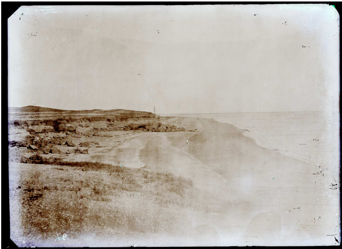
M.O.P. , PUERTO MILITAR, LA PLAYA DE PUNTA ALTA ANTES DE EMPEZAR LAS OBRAS. NEGATIVO DE GELATINA SOBRE VIDRIO DE 130X180 MM, BAHIA BLANCA, AÑO 1896. CeDIAP.
